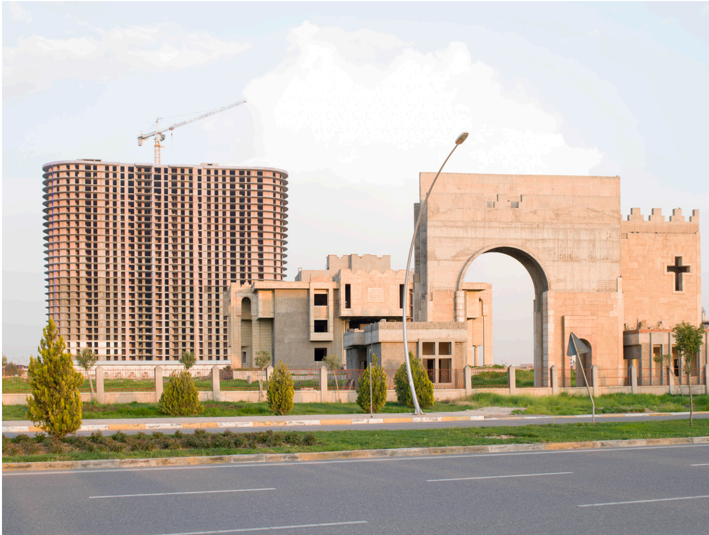
Chantier d'une gated community à l'arrêt, Erbil, 2017
