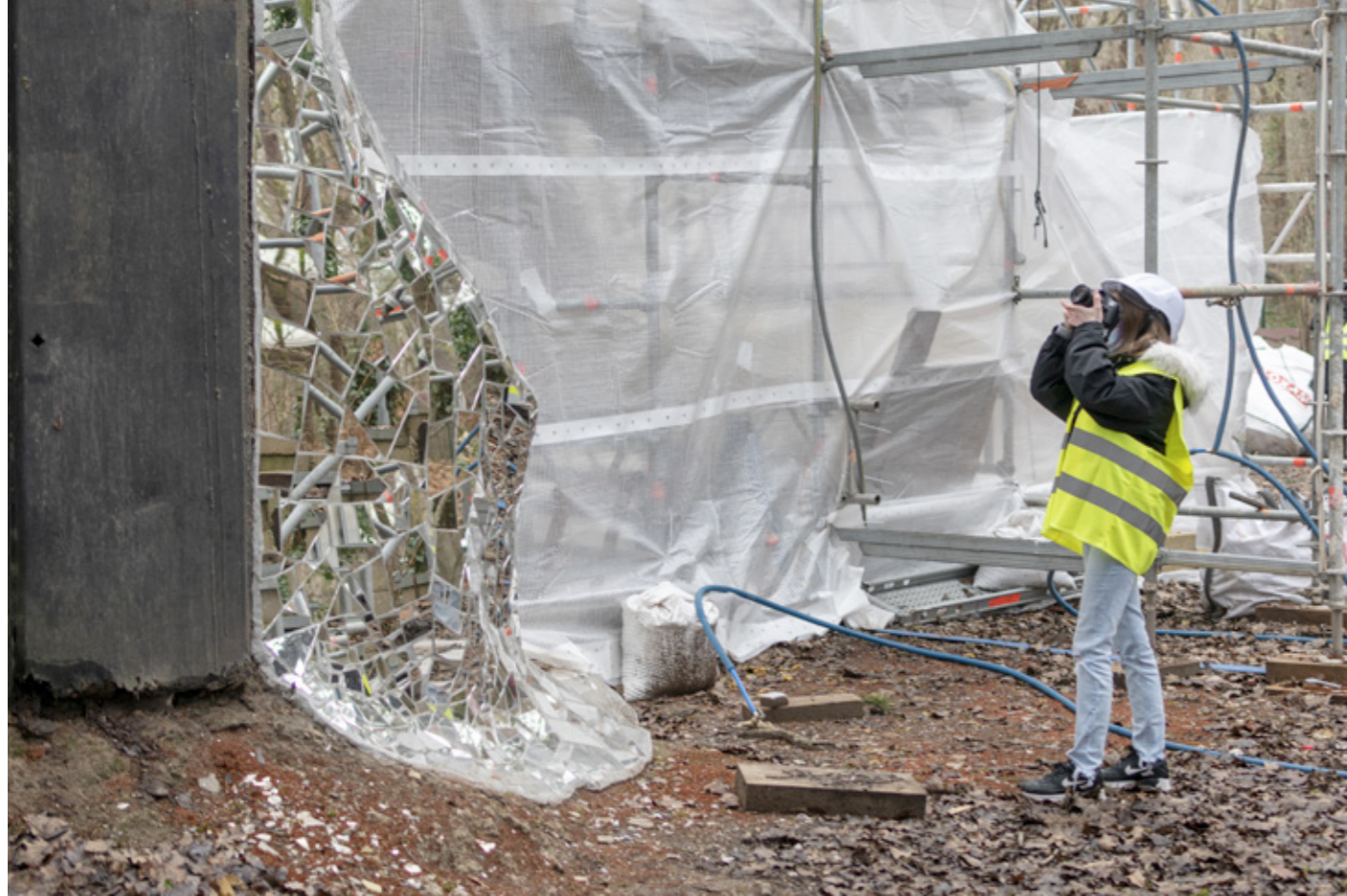
© Martin Barzilai Reportage sur le chantier de restauration du Cyclop, Milly-la-Forêt.
